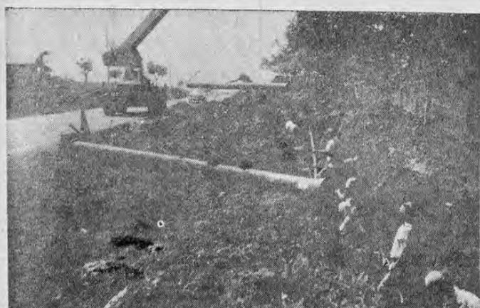
Suministro de agua potable — Maquinaria y trabajadores del Servicio Nacional de Acueductos y Alcantarillados (SNAA) laboran intensamente para mejorar el suministro de agua del área
